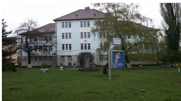
Sediul Facultății de Inginerie Energetică și Management Industrial
